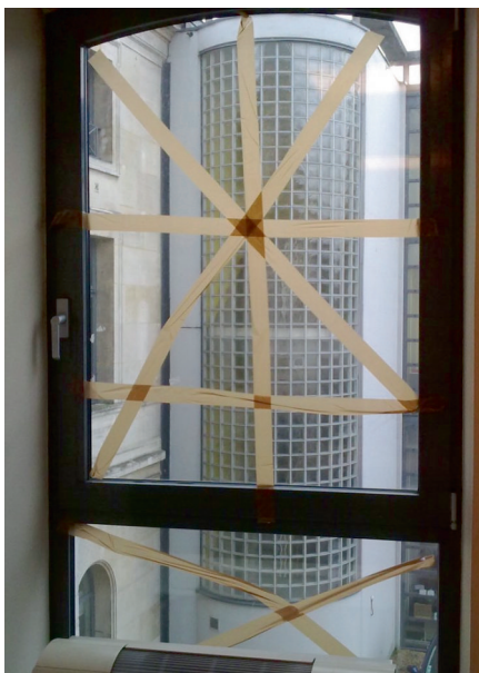
De manière préventive, les vitres peuvent être renforcées par des morceaux de ruban adhésif placés sur chaque fenêtre (zébrage)
